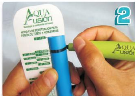
Marque la distancia de penetración en el tubo de acuerdo a la tabla.
